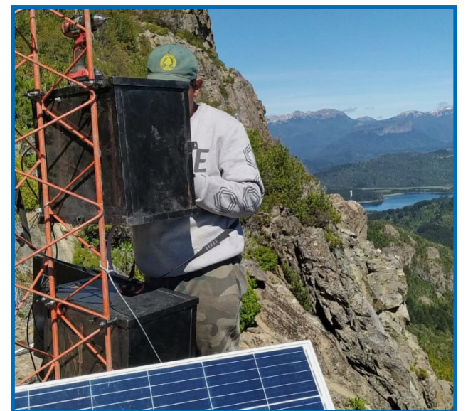
Instalación de panel solar a 1050 msnm
